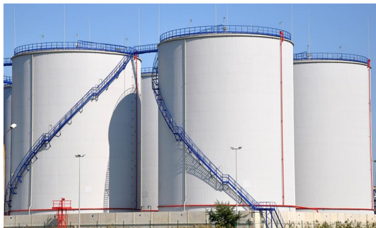
Slika 6. Spremnici za skladištenje nafte s fiksnim krovom
