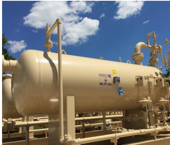
Slika 5. Vodoravni separator
