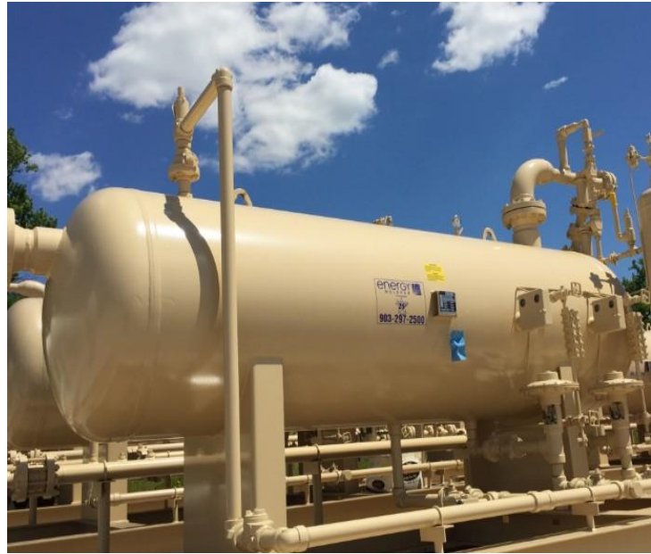
Slika 8. Vodoravni separator
