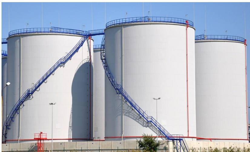
Slika 9. Spremnici za skladištenje nafte s fiksnim krovom
